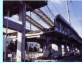
RCラーメン高架橋の被災状況
