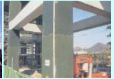
鋼板補強された高架橋柱
