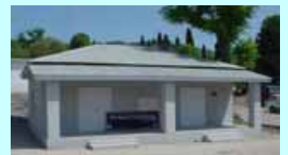
竣工した組積造住宅 (材料費は約3,000円)
