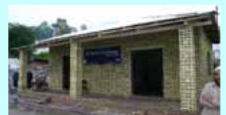
PP-band補強した組積造住宅の上塗り前
